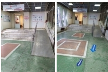
Пандус (внутри здания) № 12,13
